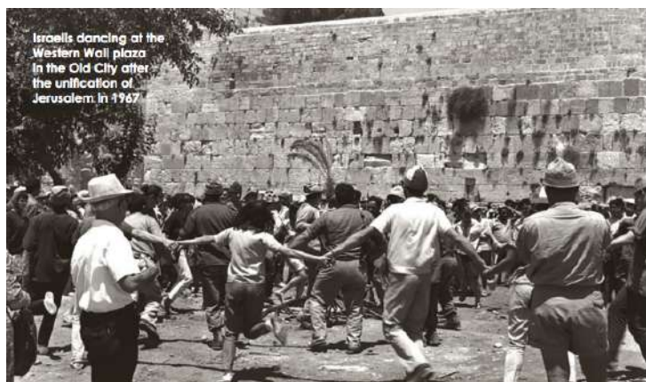
耶路撒冷1967年統一時， 以色列百姓於舊城的西牆廣場歡欣跳舞
