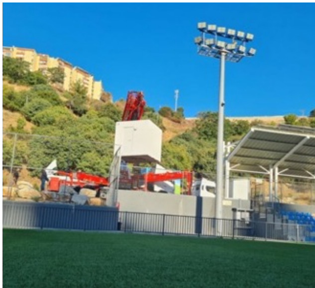
在北部城鎮采法特 ( Safed ) 安裝防空洞。(照片來源：生命盾牌行動)
